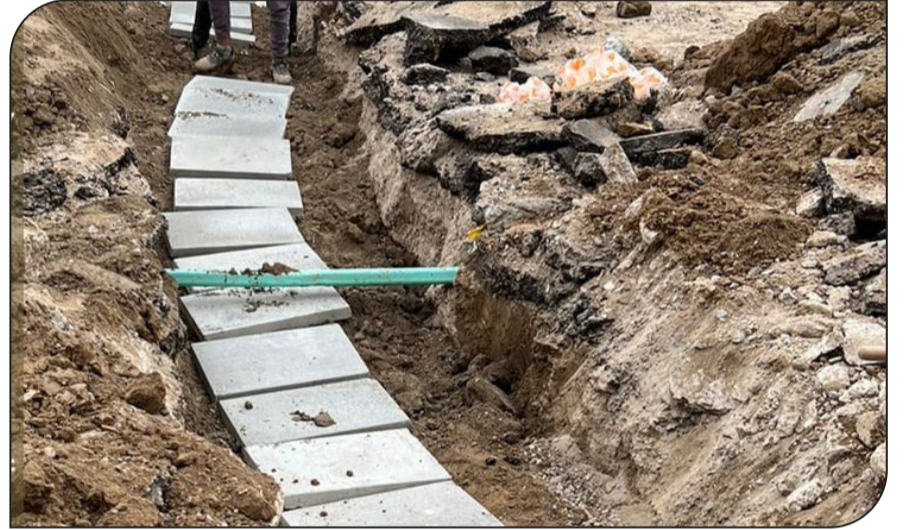
اعمال مد خط كهرباء 33Kv الى جامعة التراث
