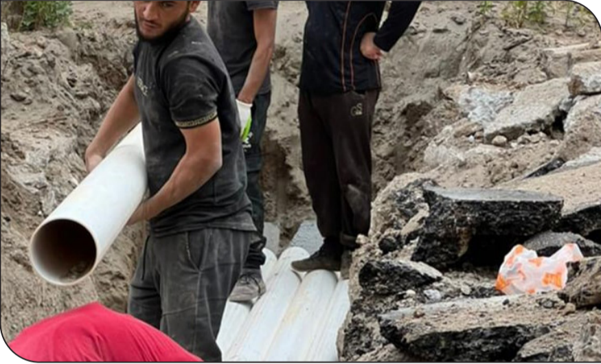
اعمال مد خط كهرباء 33Kv الى جامعة التراث
